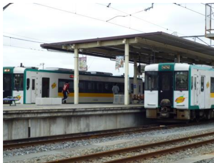
石巻駅(仙石線) 電気設備が復旧していない為、ディーゼル車両が使われています。内陸に路線を移し15年度内の全線復旧を目指しています。
