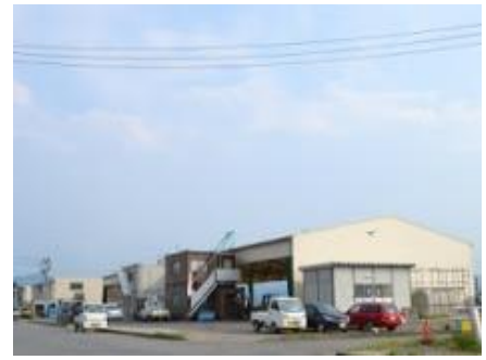
陶器市開催会場(魚市場)付近 まだ一部工事をしていましたが、ほぼ きれいに整備されています。周辺の加工 工場も多く稼働していました。
