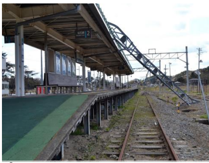
野蒜駅周辺(JR仙石線) 陸前大塚駅から陸前小野駅までについては線路を内陸に移設し2015年度内の全線復旧を目指す
