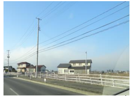
関上港付近のガードレールも大きく曲がったまま、未だその時の様子をとどめていました。
