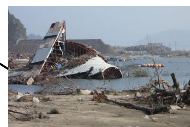
両方向からの津波により半島の 付け根が水没。
